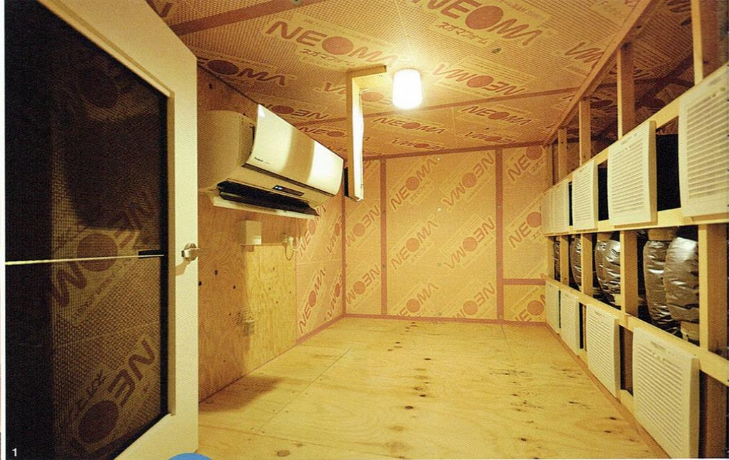
1.小屋裏には、エアコン1台で家中の温度を管理できる空調室が。扉(写真左)にもフィルターを取り付け、家中にクリーンな空気を送れる仕組みになっている。 2.ピンクでまとめられたかわいらしい洗面室は、物干し場としても使用。「全館空調のおかげで洗濯物もよく乾きます」(奥様)。 3.ホテルライクな空間を目指した寝室。ブラウン系のクロスと間接照明で、上質な雰囲気を演出している。 4.キッチンはアイランド型を採用。大容量の背面収納で、奥様の家事効率もアップ。 5.吹き抜けでリビングと繋がる2階ホール。「広く取ってもらい、収納棚も設けました。子どもが成長したら、遊び場として使いたいですね」(ご主人)。 6.淡い色のサイディングを張り分け、優しい雰囲気に仕上げた外観。太陽光パネルを搭載した屋根は、南向きに傾斜させた。
